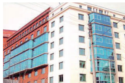
Объект: Жилое здание, г. Воронеж Поставщик: ПБЮЛ Сураев «Евросантехника»
