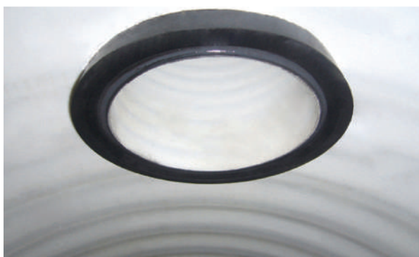
4. Вид изнутри трубы после монтажа.
