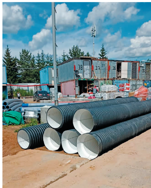
Объект: объездная дорога, г. Киржач, Владимирская область. Подрядчик: ООО «Аврорастройпроект».
