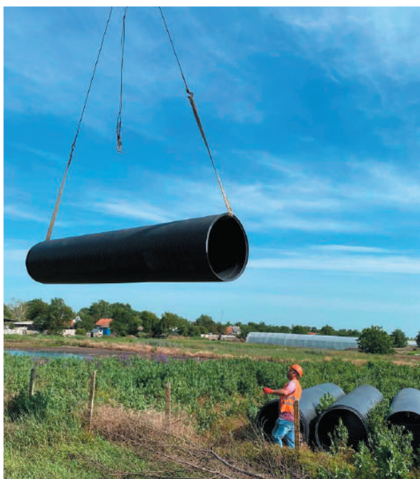
Объект: капитальный ремонт запорного коллектора, п. Красногвардейское, Республика Крым. Подрядчик: ООО «ТЕХНОПАЙПГРУПП».
