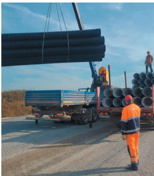
Объект: ЦКАД, Московская область. Подрядчик: Компания «АКС».
