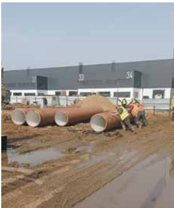
Объект: Складской комплекс, г. Подольск, Московская область. Подрядчик: «Атлант-сервис».
