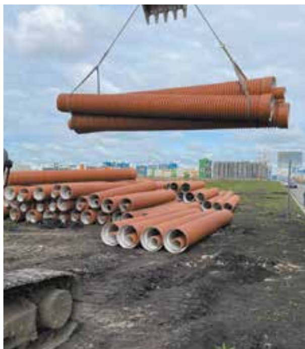
Объект: ЖК GRAND PARK, г. Пенза. Подрядчик: Компания «Рускомплекс».
