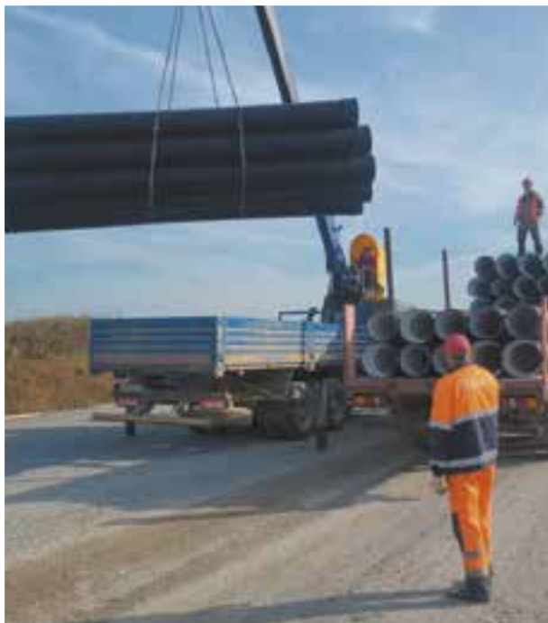
Объект: ЦКАД, Московская область. Подрядчик: Компания «АКС».
