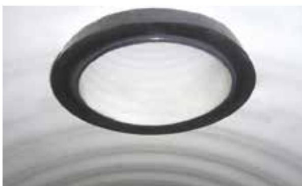
4. Вид изнутри трубы после монтажа.
