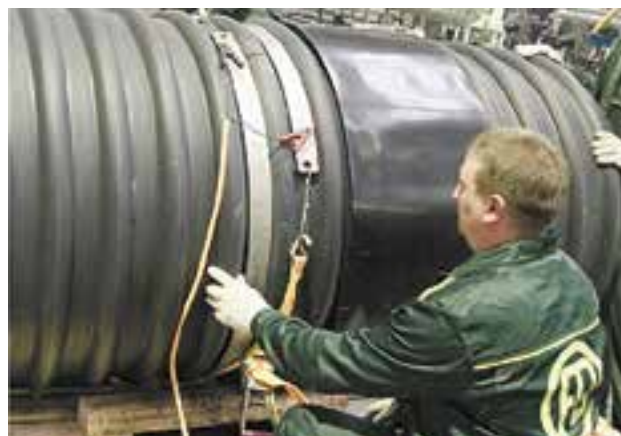
Рисунок 15. Схема соединения труб с помощью уплотнительного кольца
